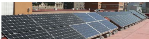
Cubierta solar fotovoltaica ETSIDI
