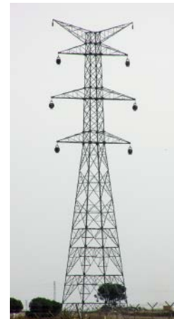
Apoyo alta tensión
